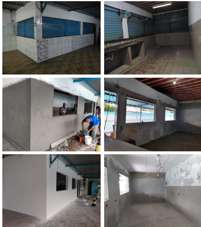
Fotos do andamento da obra
